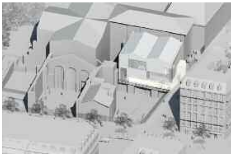
En plus clair : le nouveau bâtiment de Cluny IV, tel qu'il sera implanté dans le site.
