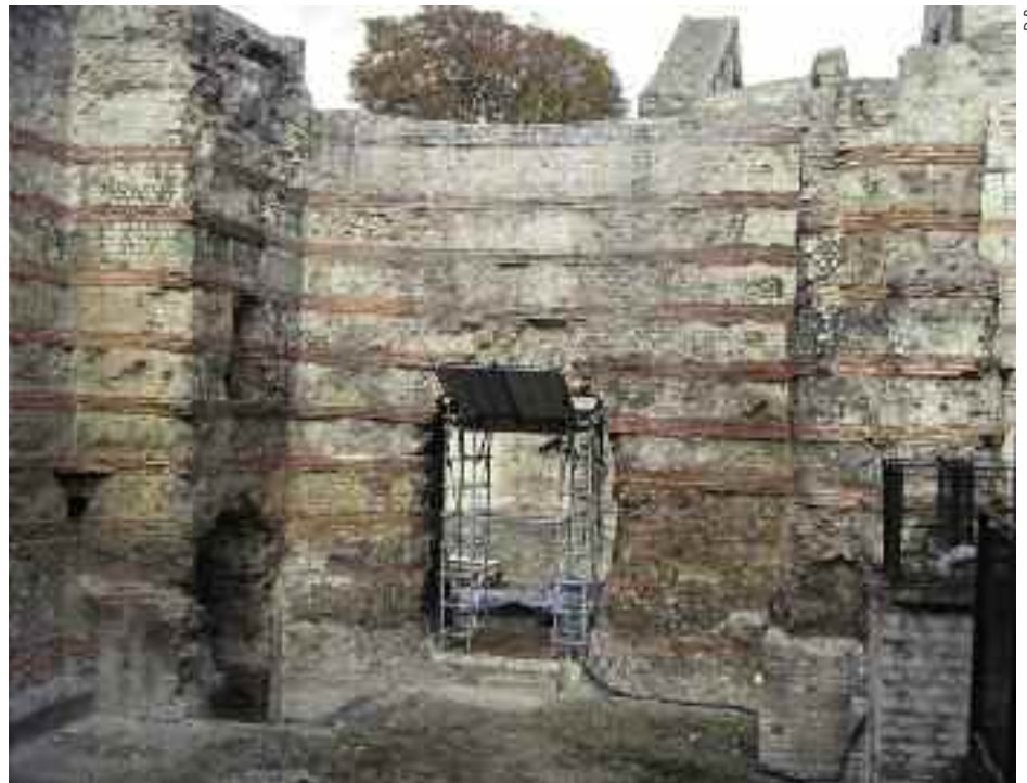
Les thermes vues de la rue Du Sommerard, avec le bardage qui protège de la chute des pierres.
